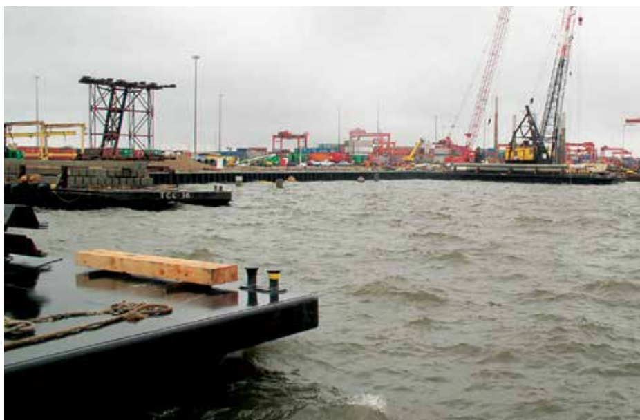
Вид на строительную площадку
