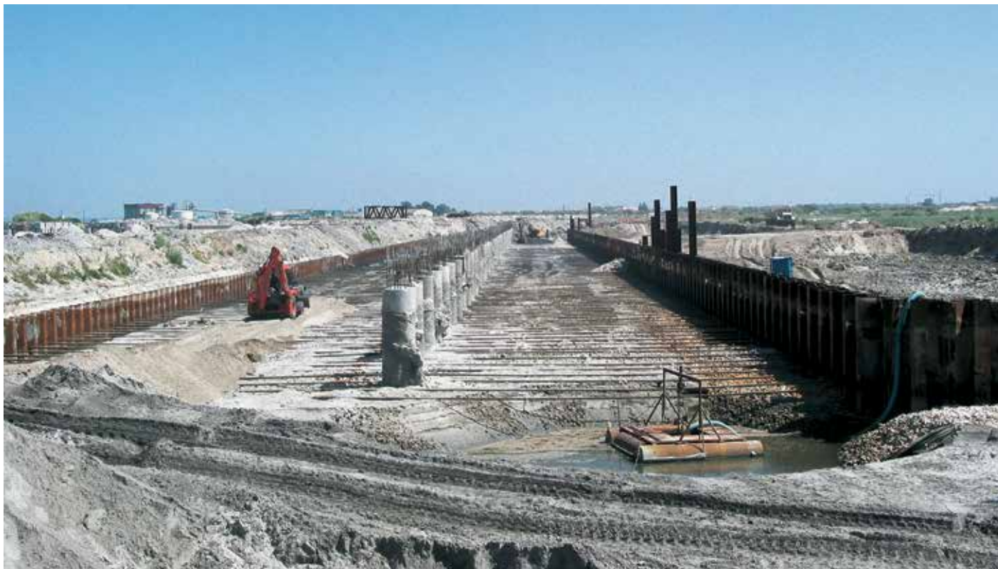
Крановые нагрузки приходятся на лицевую стенку и на подкрановые бетонные колонны.
