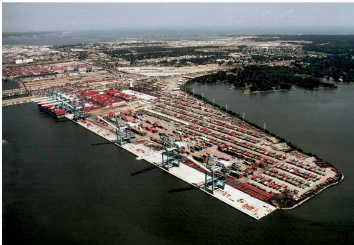
Южный причал МТН реконструировали с сооружением двух рядов стальных шпунтовых стенок.
