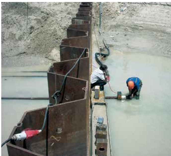
Установка анкерных тяг над уровнем воды для облегчения процесса их монтажа.
