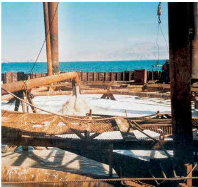
Шпунтовые ячейки, как правило, заполняются намытым на месте песком.
