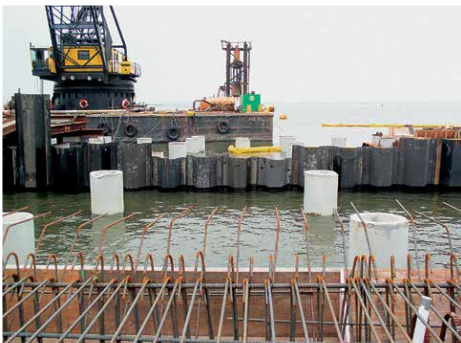
Шпунтовые сваи AZ 36 воспринимают статические нагрузки и служат водонепроницаемым барьером.
