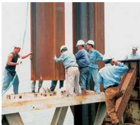
Двухуровневый направляющий кондуктор обеспечивал вертикальность основных свай при погружении.
