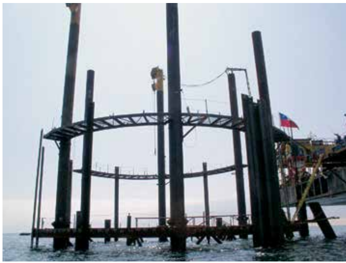
Волнолом состоит из восьми ячеек диаметром 24 м.
