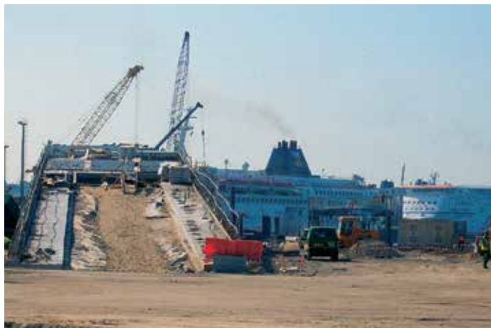
Строительство трапа на верхнем уровне.
