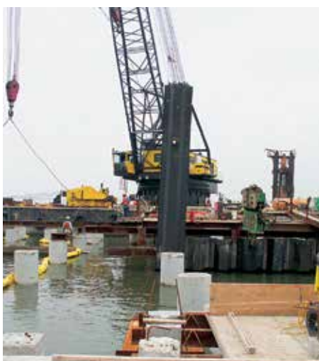
Кондуктор обеспечивает прямолинейность шпунтовой стенки.
