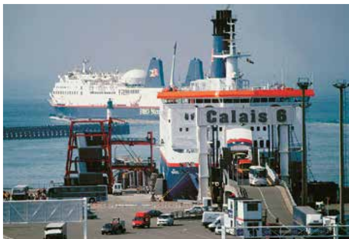
Новый Причал 9 оборудован более широкими трапами и способен принимать суда большего размера.
