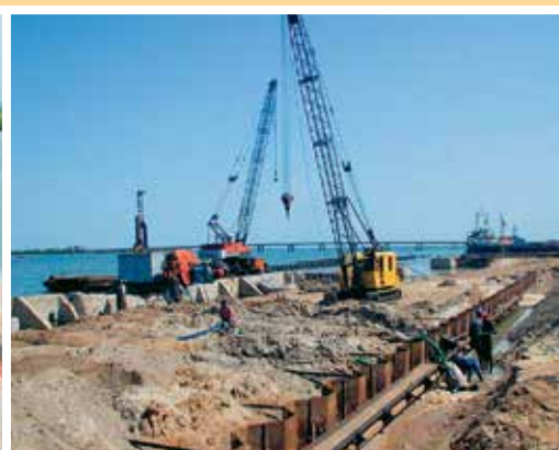
Новую причальную стенку построили из стальных шпунтовых свай типа AU 21 на расстоянии 20 м перед существующей стенкой.
