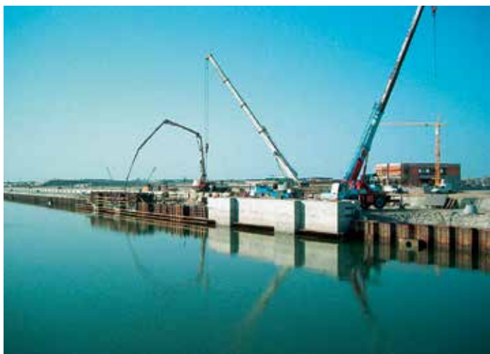
Устройство бетонного ростверка и установка отбойников и причальных тумб.
