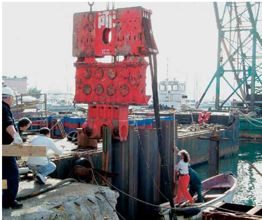
Погружение шпунта выполнено с использованием вибропогружателя RTC и направляющего кондуктора.
