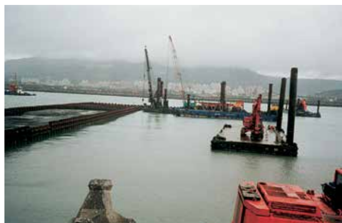
Установку свай и отсыпку территории вели с разных барж.
