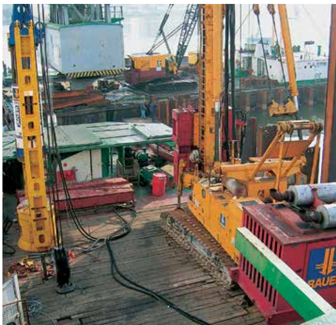
Оборудование для погружения свай компании Bauer: ударный молот и вибропогружатель.
