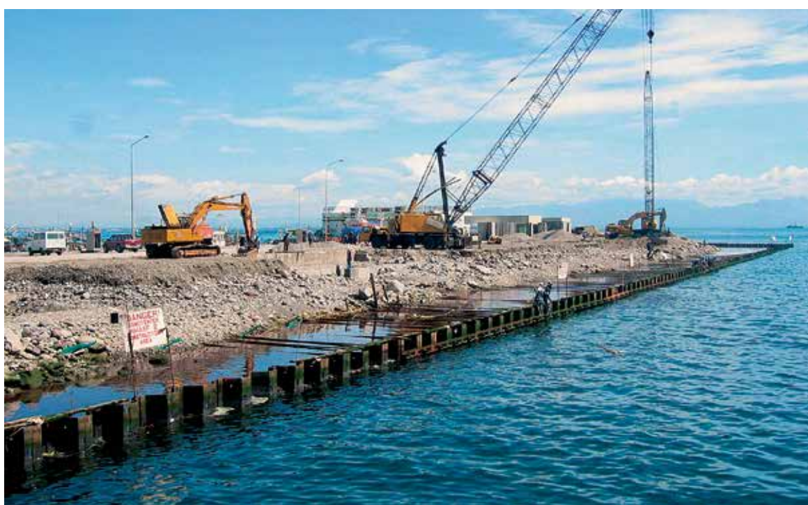
В соответствии с требованиями развивающейся рыбной промышленности построили две новых причальных стенки из шпунтовых AZ-свай.
