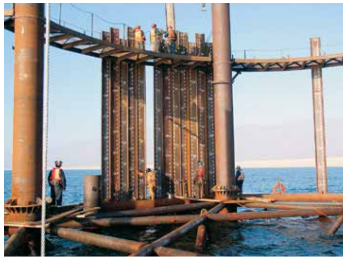
Для формирования ячеек волнолома сваи плоского профиля погружали с помощью кондуктора.
