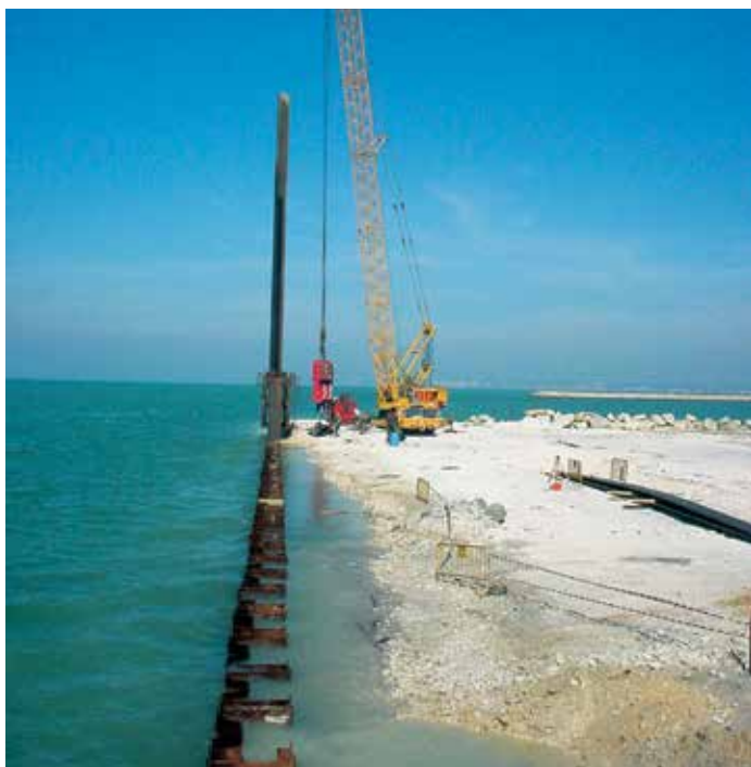
Отсыпанная намытым песком территория служила площадкой для работы сваебойного оборудования.
