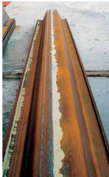
Замковые соединения свай были заполнены герметизирующим наполнителем Rohan, расширяющимся при контакте с водой.
