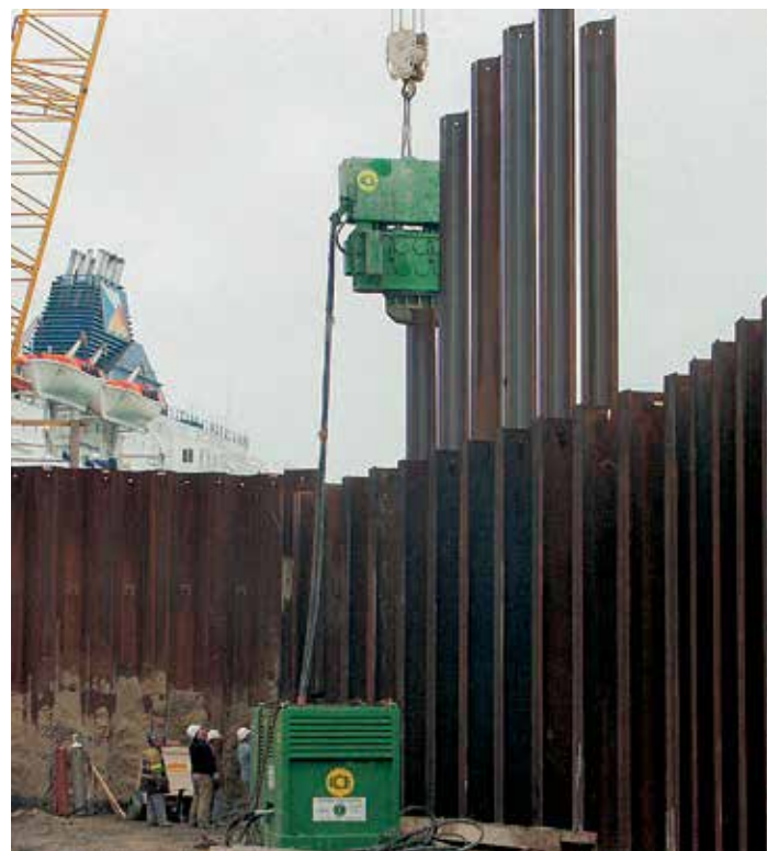
Вибропогружение промежуточных свай типа AZ 12 длиной 21,6 м.
