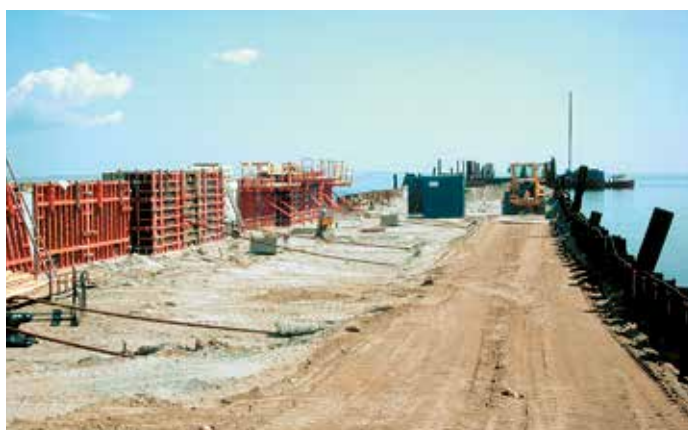
Опалубка для железобетонного оголовка.
