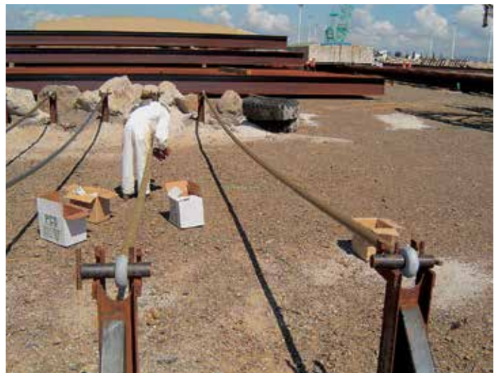
Анкерные тяги обернули противокоррозионной защитной лентой.
