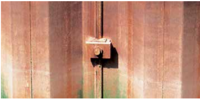
Место соединения анкерной тяги и сваи AZ 17.
