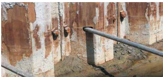
Узел соединения анкерных тяг и шпунтовой стенки.
