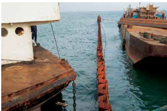
Оба причала построили с использованием 380 двойных шпунтовых свай типа AZ 34 и 80 двойных свай типа AZ 26.
