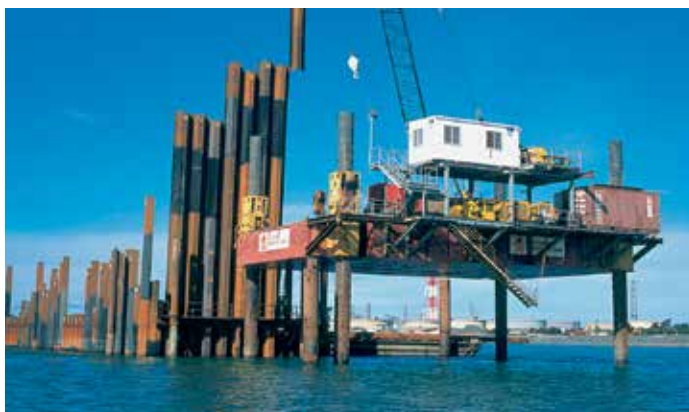
Погружение лицевой шпунтовой стенки с самоподъемной баржи Flexifloat S-70.
