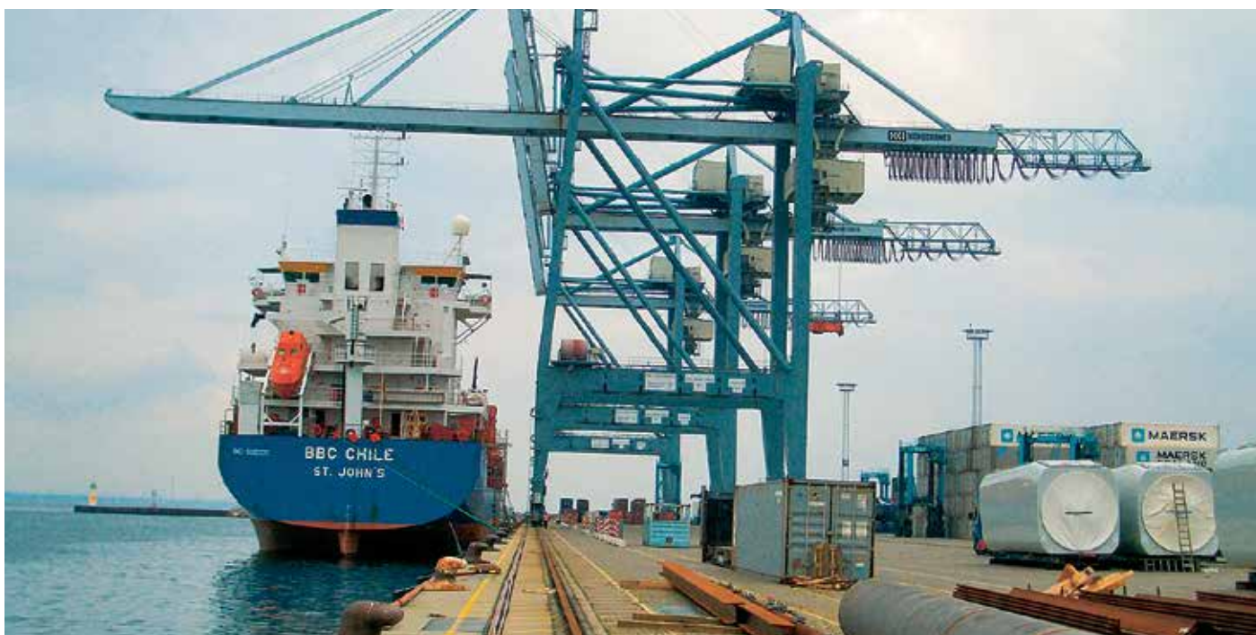
Участок действующего Восточного контейнерного терминала.
