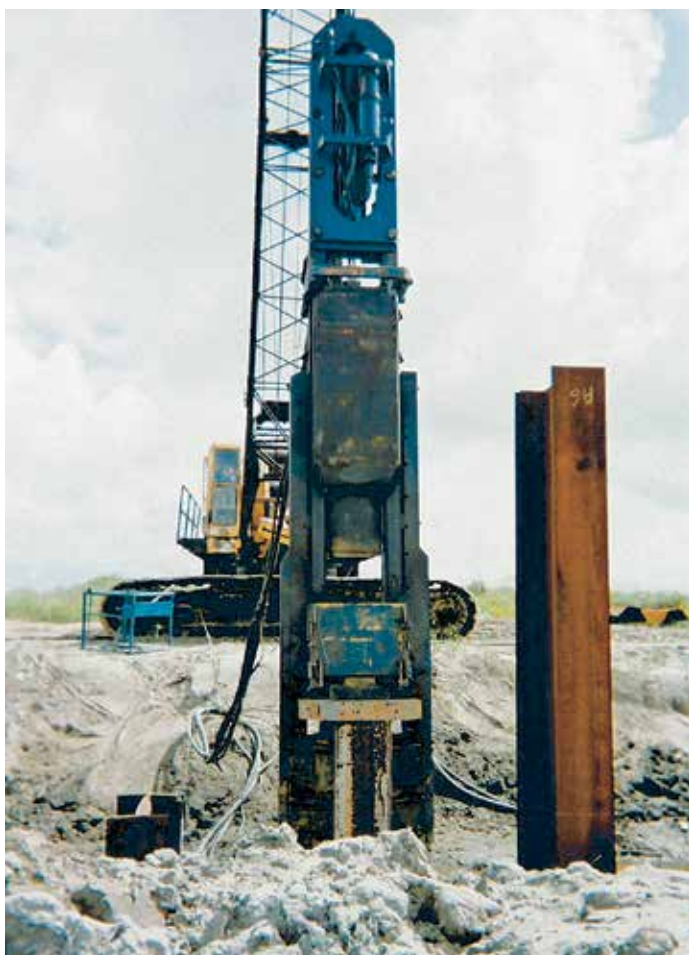
Благодаря кондуктору AZ-сваи точно входят в промежутки между основными HZ-сваями.
