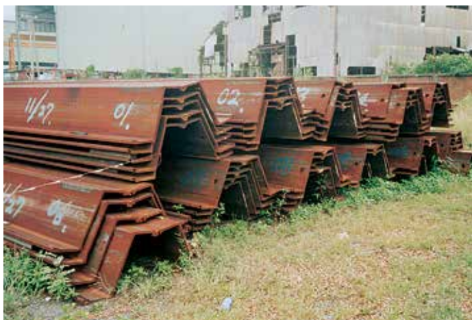
Значительное дноуглубление и сейсмические нагрузки требовали применения сверхмощных секций AZ 48.
