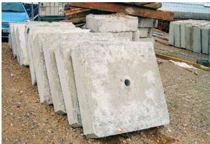
Железобетонная анкерная плита размером 1000 x 1000 x 300 мм.
