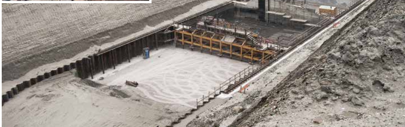
Свыше 6000 тонн стальных шпунтовых свай пошло на устройство шпунтовой стенки.
