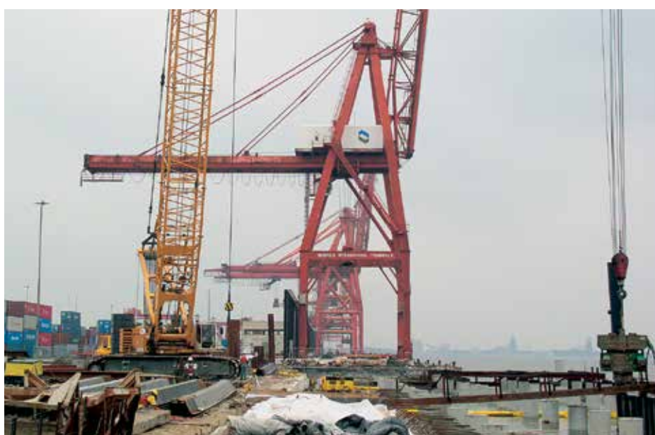
Монтаж с помощью крана, установленного на прибрежной части, оборудованного вибропогружателем.
