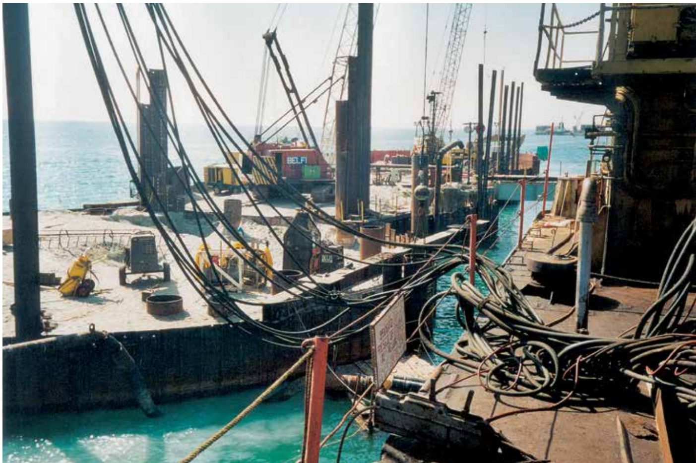
Залпненные грунтом ячейки способны выдерживать вес строительного оборудования.
