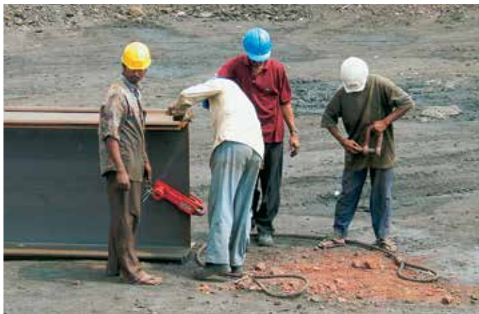
Для подъема основных свай использовались мощные захваты.
