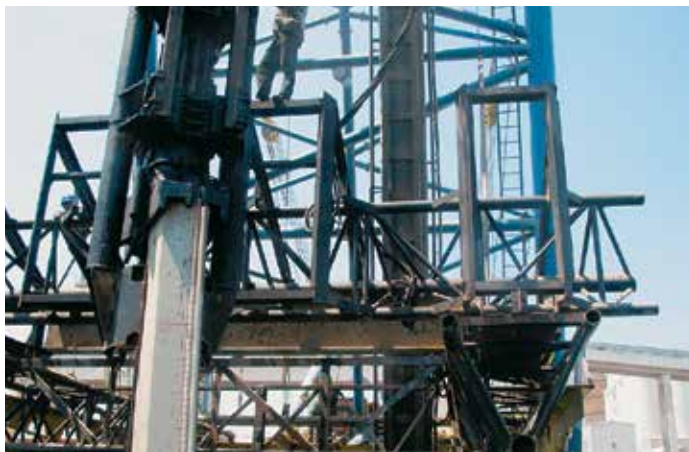
Резиновые накладки предохраняли покрытие свай от повреждений во время погружения.
