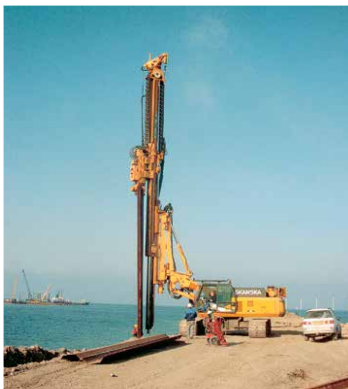
Сваи типа PU 8 на участке бермы погружали с помощью вибропогружателя, установленного на экскаваторе.
