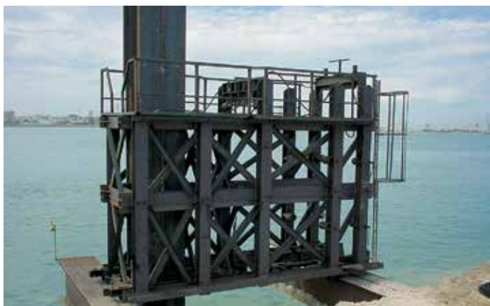
Направляющий двухуровневый кондуктор для погружения свай.
