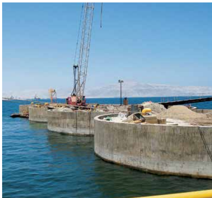
Бетонные оголовки защищают головы шпунтовых ячеек.
