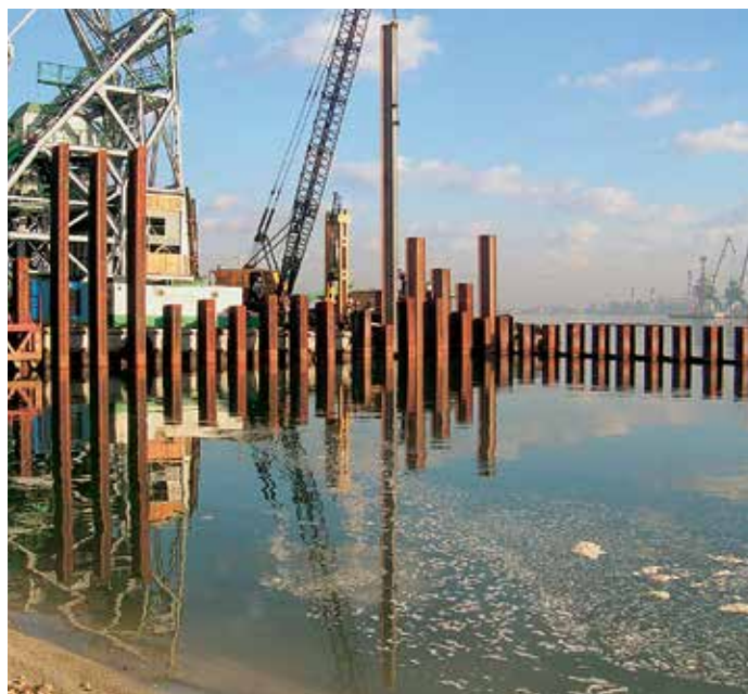
Забивка несущих HZ-свай на углу L-образной стенки.
