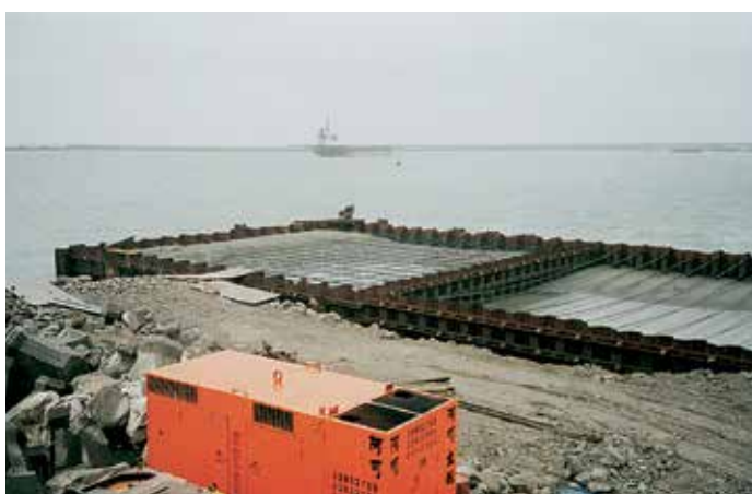
Открылок Причала 15 длиной 27,4 м состоит из комбинированной системы с 14 основными HZ-сваями.
