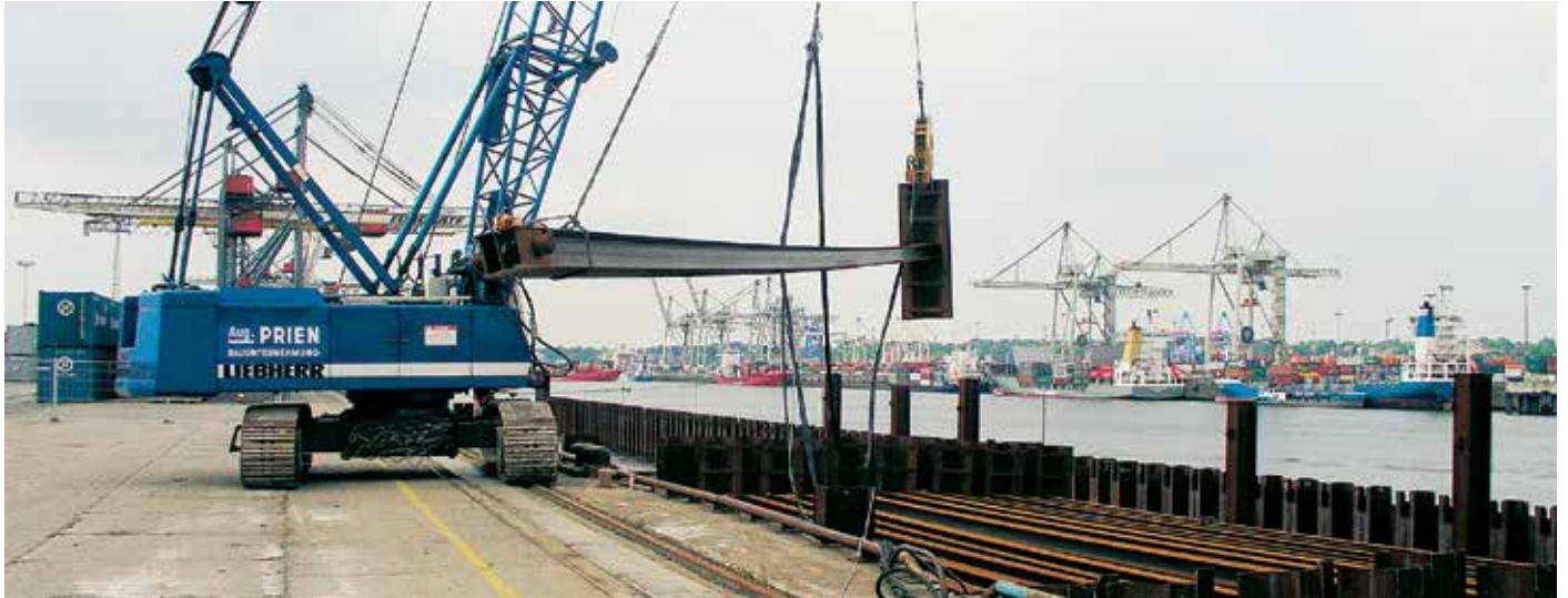
Кран поднимает сборные анкерные сваи для установки в проектное положение.
