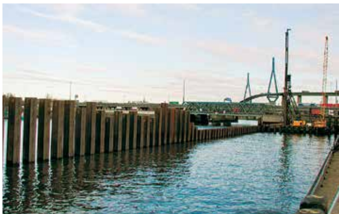
Погружение HZ-свай выполнялось с использованием двухуровневого кондуктора.
