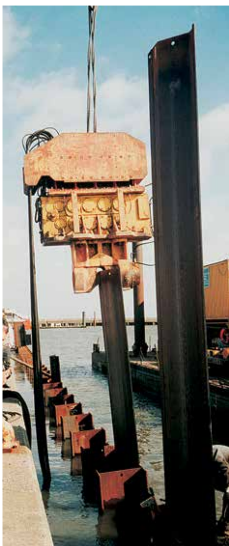
Вибропогружатель идеально подходил для установки промежуточных AZ-свай.
