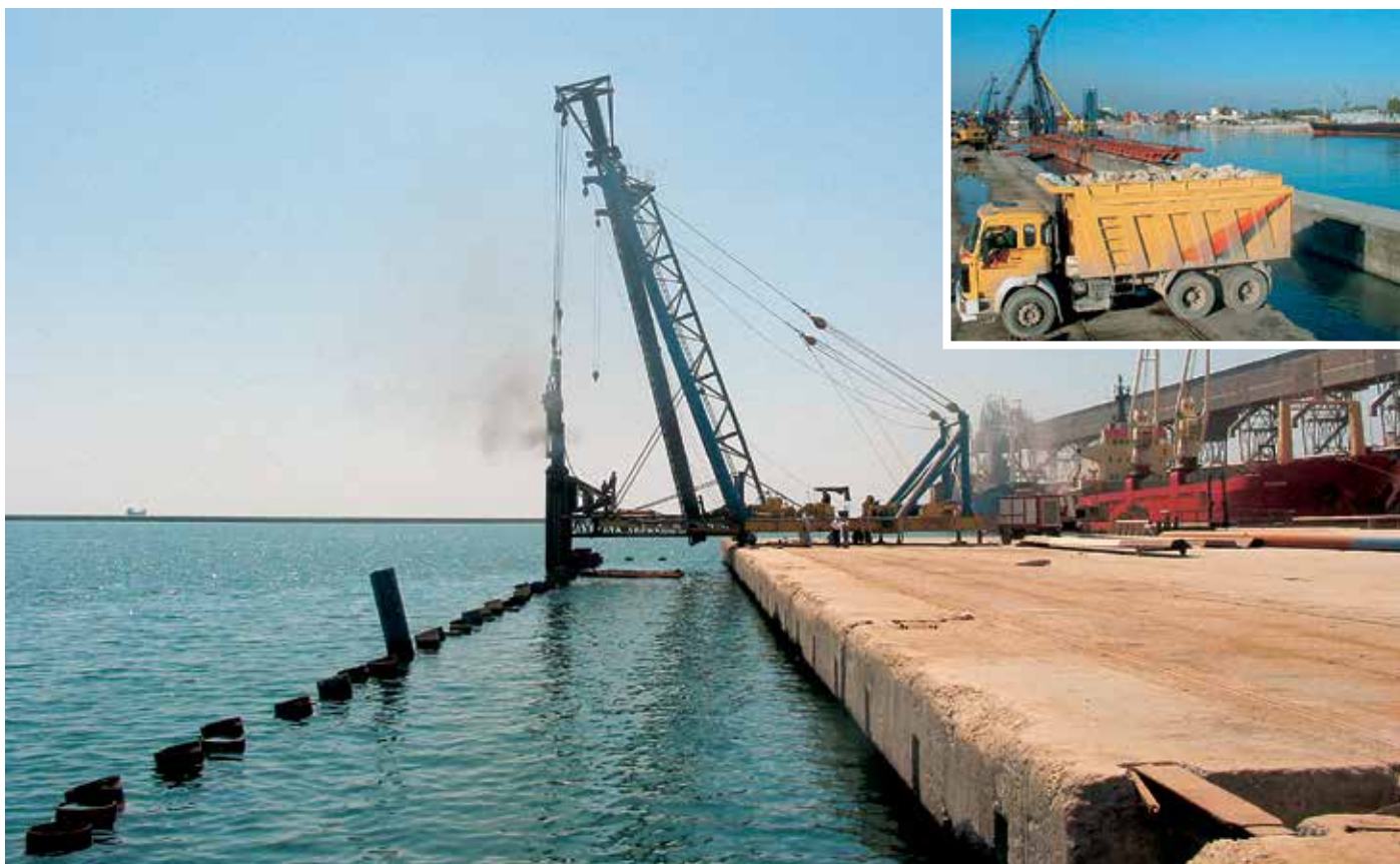
Опорой для платформы с навесным оборудованием служило бетонное строение старого причала.
