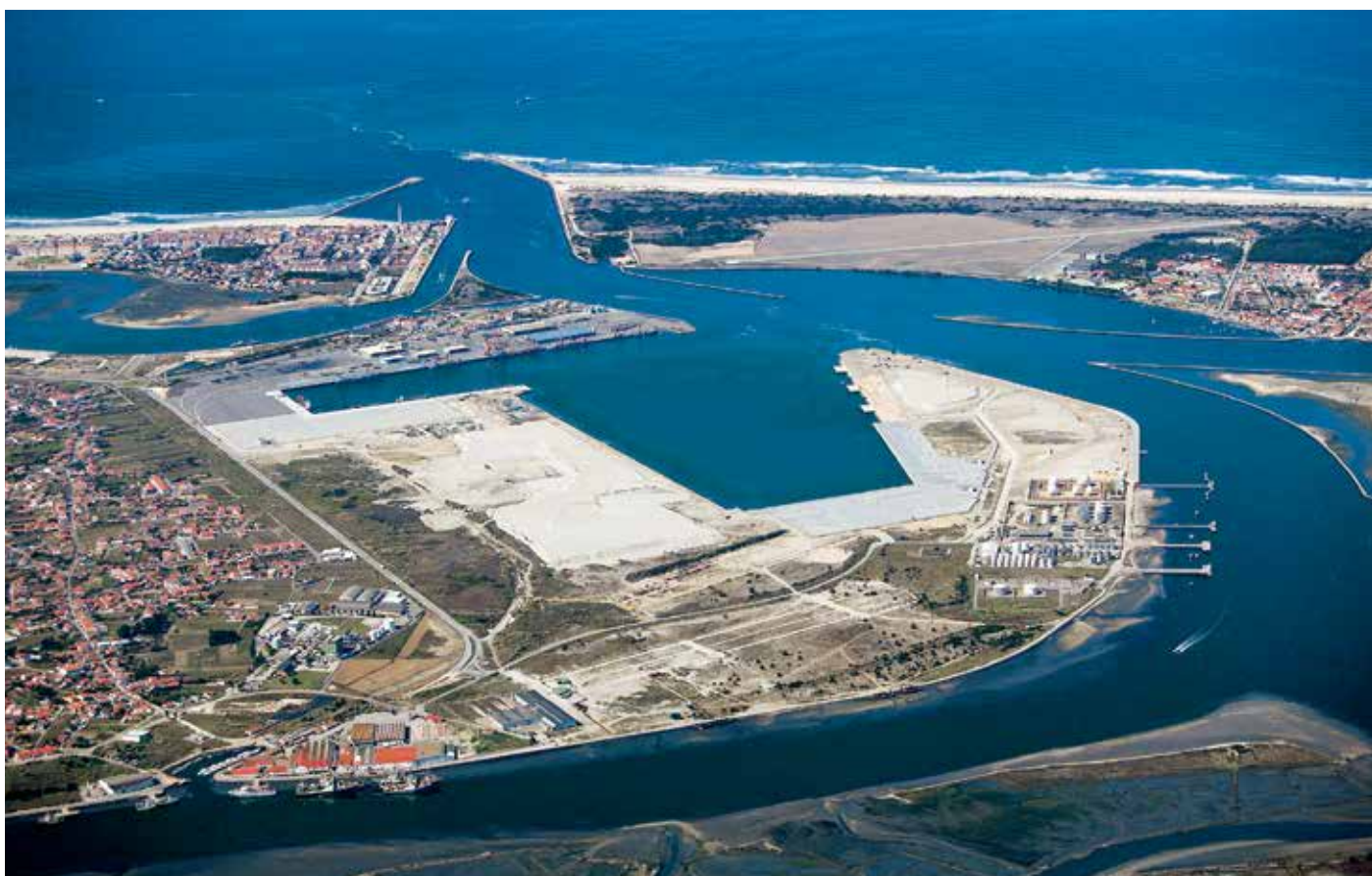
Строительство обоих причалов – 450-метрового для с/х продукции и 300-метрового для насыпных грузов, завершили в 2005.
