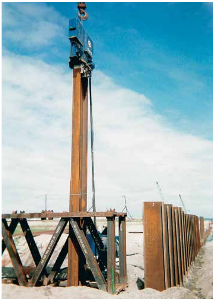
Двухуровневый кондуктор обеспечивал прямолинейность при погружении HZ-свай.
