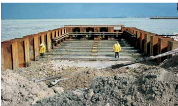
Пирс в северной части причала Кабесуэла.
