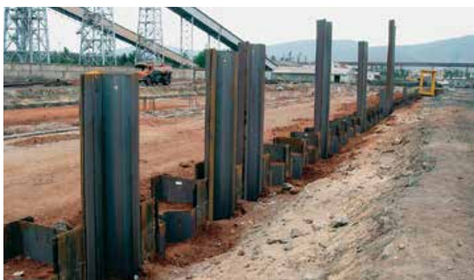
Индийское проектное бюро Howe приняло решение в пользу применения комбинированной шпунтовой системы HZ/AZ с анкерной стеной.
