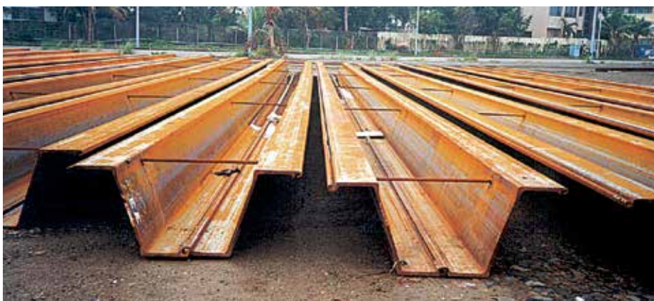
Приваренные арматурные стержни предотвращают смещение замковых соединений, что позволяет четко уложиться в проектную длину стенки.
