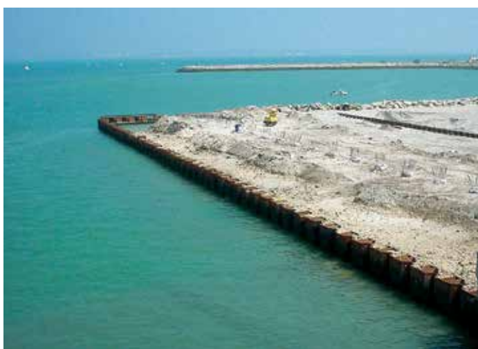
Обратная засыпка территории нового причала после завершения работ по погружению шпунтовых свай.
