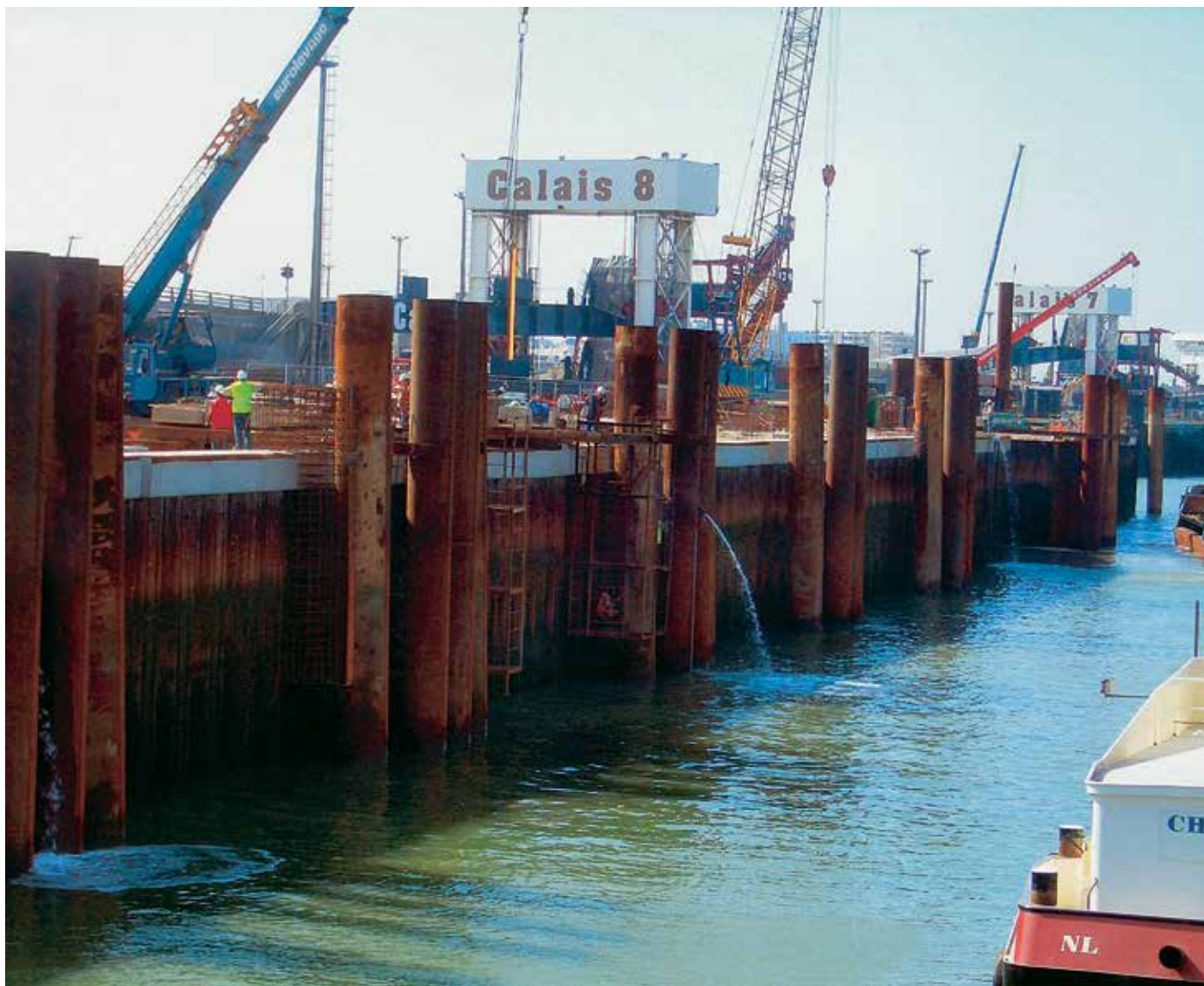
Стальные трубы, забитые в причальную стенку, будут служить отбойным устройством.
