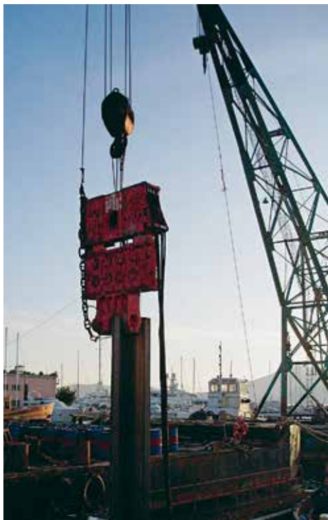
Погружение шпунта выполнено с использованием вибропогружателя RTC и направляющего кондуктора.
