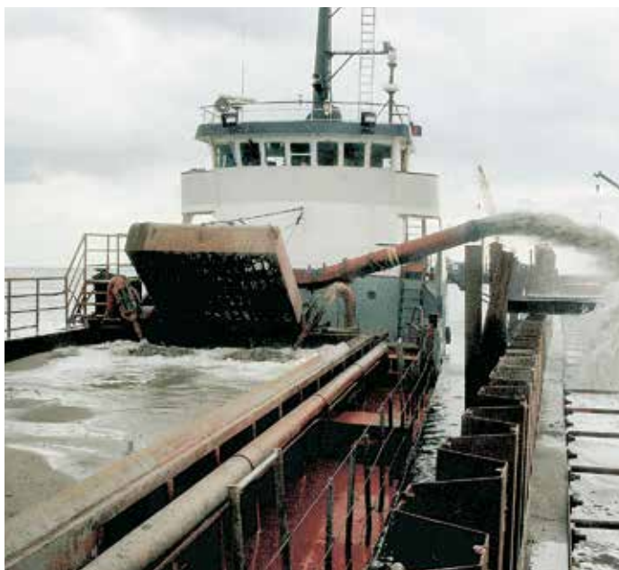
Отсыпка коффердама намытым песком.
