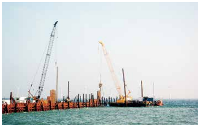
Строительство взаимозаанкеренного коффердама на территории открытой акватории.
