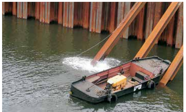
Под углом 32° включили вибропогружатель для безопасной установки анкера.
