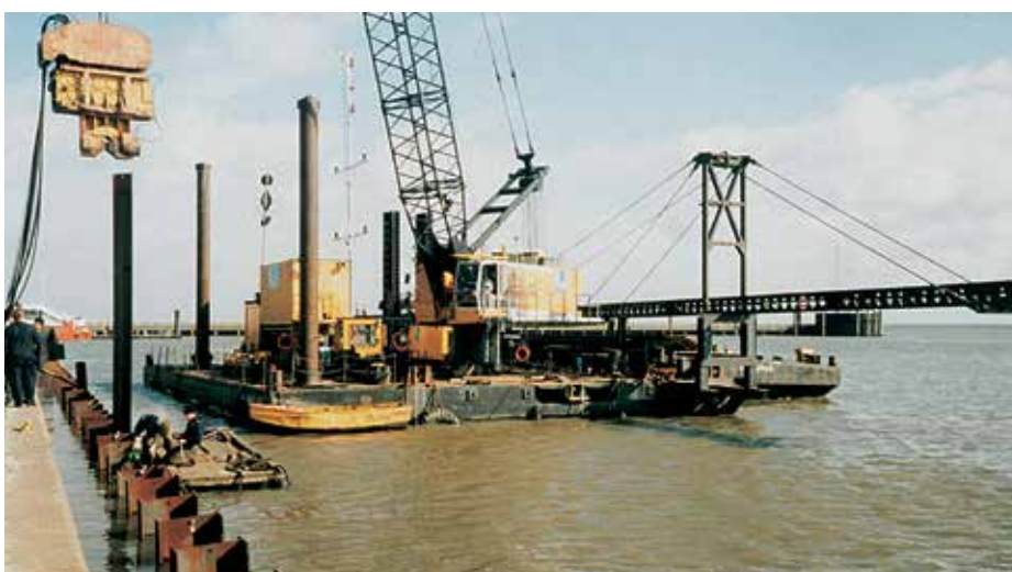
После установки основных свай погружали промежуточные элементы AZ до отметки -20м.
