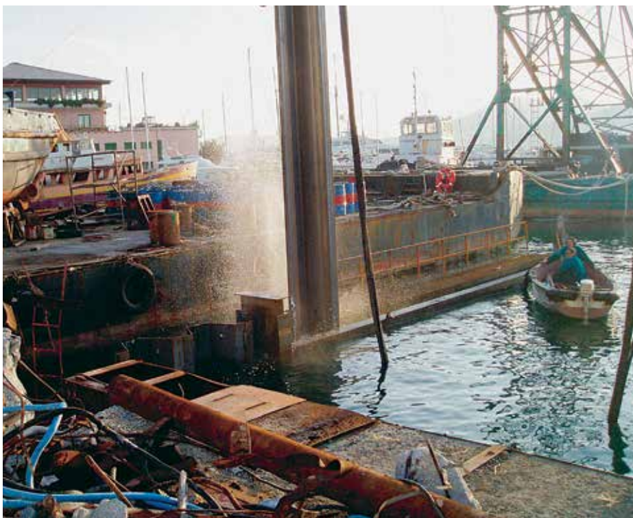
Было погружено 2600 т шпунтовых свай типа AZ 36 длиной 24 м и AZ 18 длиной 8 м.
