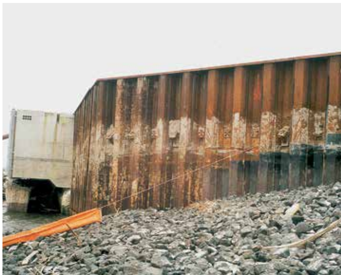
Строение с обеих сторон завершается шпунтовой стенкой.
