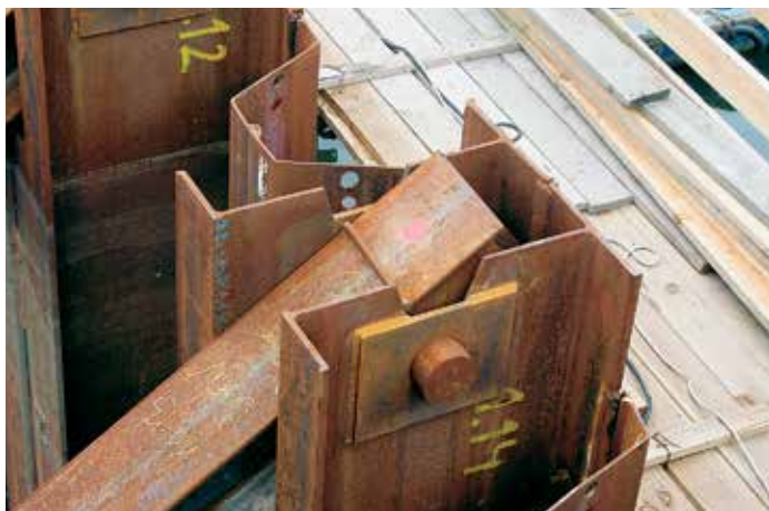
Шпилька диаметром 170 мм образует ось анкерной системы.
