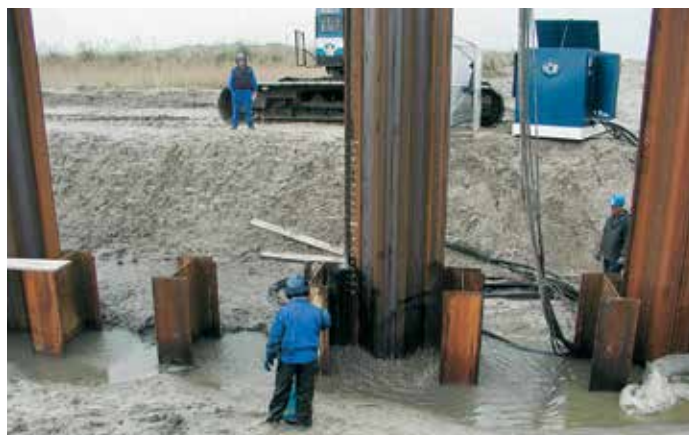
Шпунт погружали вибропогружателем до отказа.
