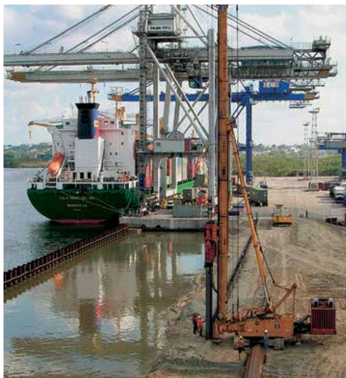
Часть свай погружали с помощью оборудования, установленного на барже, остальные – с помощью оборудования с берега.
