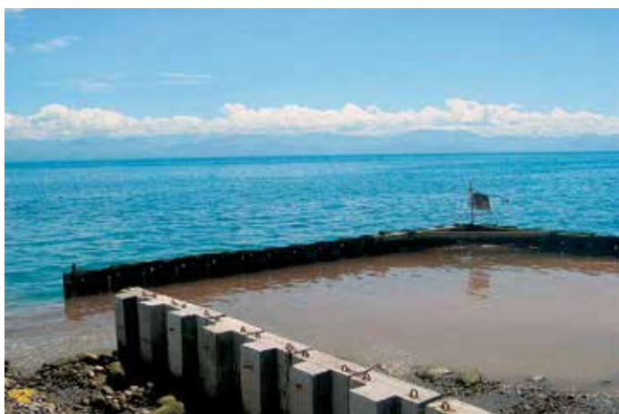
Оба причала построили с использованием 380 двойных шпунтовых свай типа AZ 34 и 80 двойных свай типа AZ 26.
