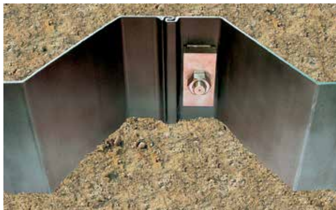
Модель узла крепления анкерной тяги нижнего уровня.
