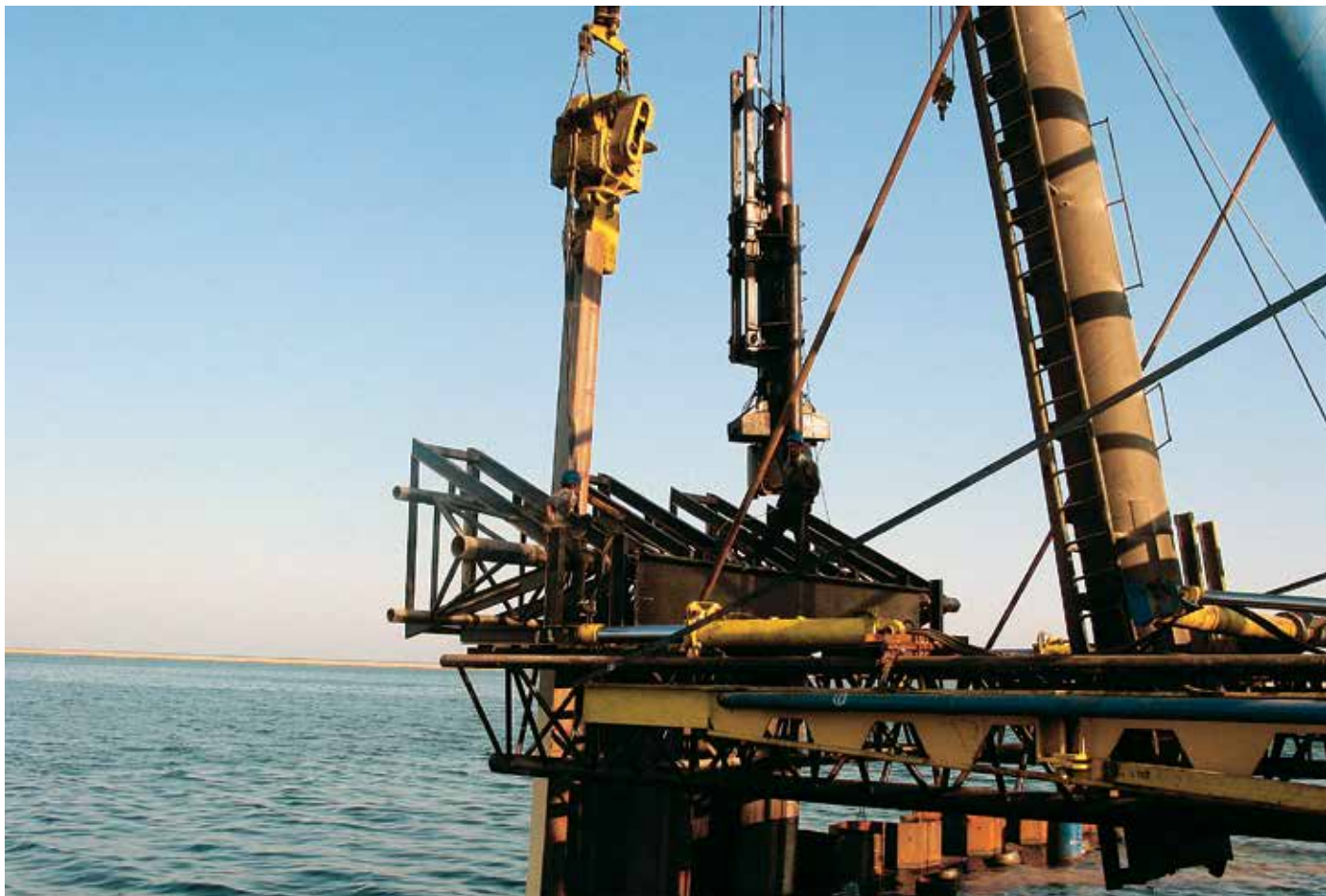
Вибропогрузатель и ударный молот разместили на специально разработанной навесной платформе на рельсовом ходу.
