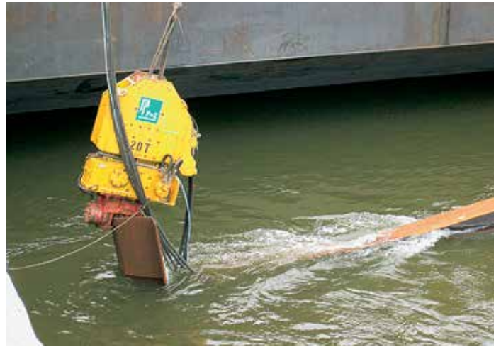
Установка анкерной системы с помощью вибропогружателя.
