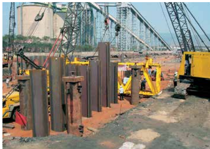
Направляющий кондуктор изготавливался в Индии на основании чертежей, предоставленных компанией ArcelorMittal.
