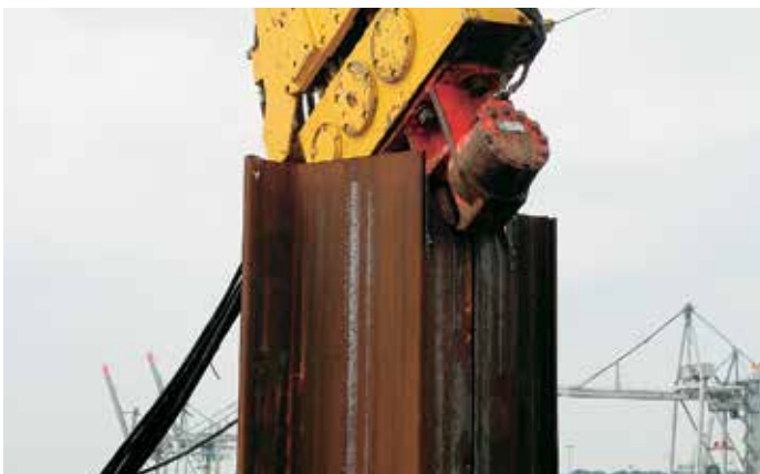
Два надреза на полке AZ-сваи для предотвращения заклинивания вибропогружателя.
