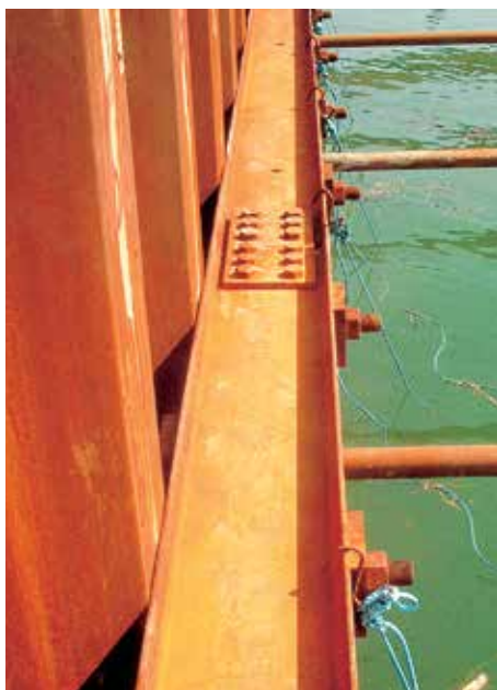
Распределительный пояс верхнего уровня анкерной системы.
