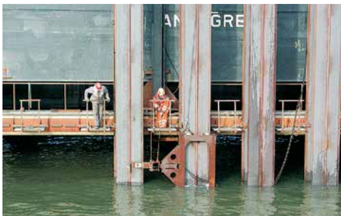
Скользящий направляющий механизм типа «салазки», установленный на нижний конец HZ-свай.
