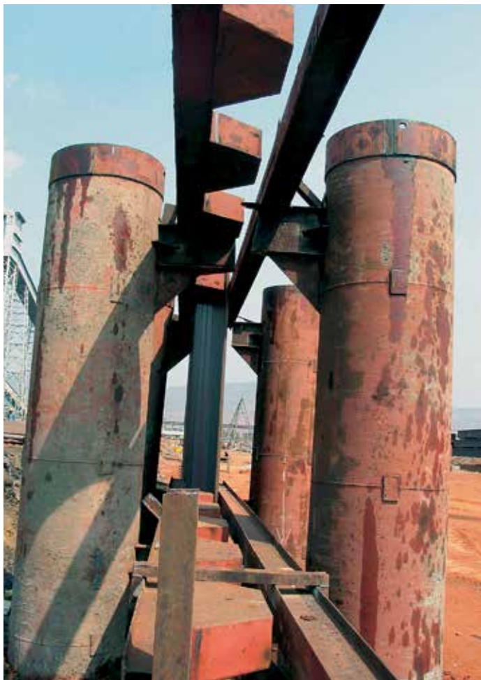
Двухуровневый кондуктор обеспечивает корректное положение шпунтовых свай в горизонтальной и вертикальной плоскостях.
