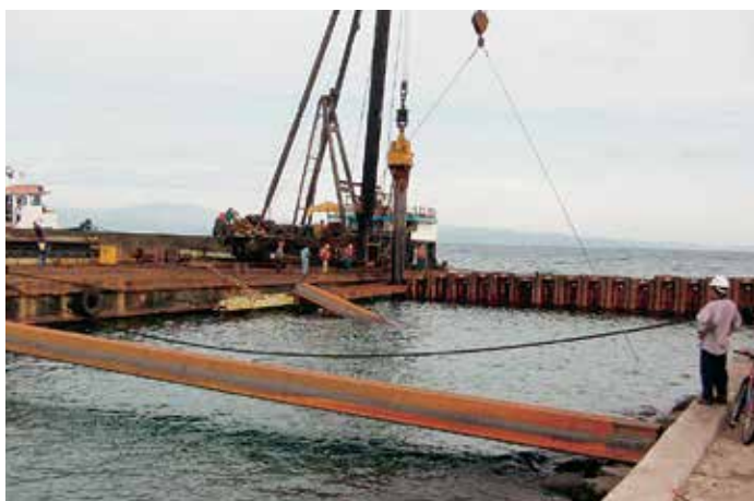
Оба причала построили с использованием 380 двойных шпунтовых свай типа AZ 34 и 80 двойных свай типа AZ 26.
