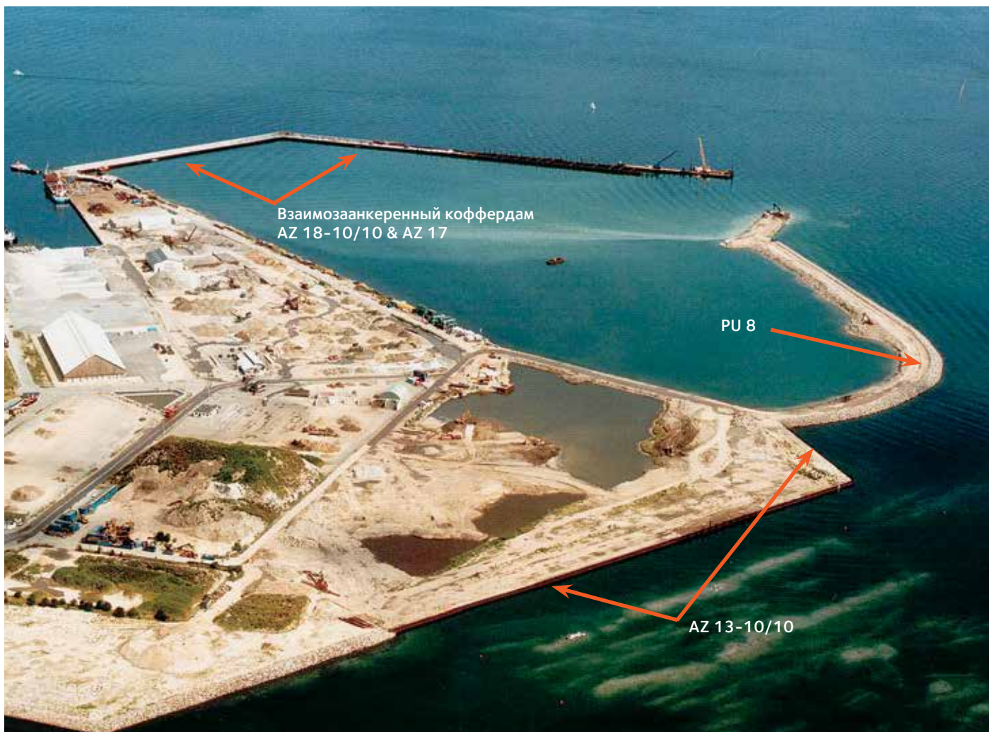
При строительстве коффердама, выполняющего одновременно роль ограждающего и причального сооружений, использовались разные типы стальных шпунтовых свай.
