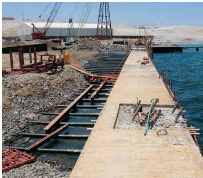
Бетонная обвязочная балка служит опорой для отбойников и причальных тумб.
