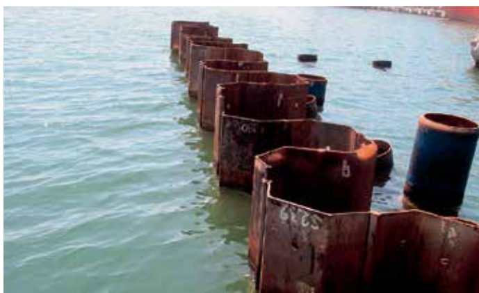
Благодаря новой шпунтовой стенке протяженностью 624 м место для швартовки судов увеличится.
