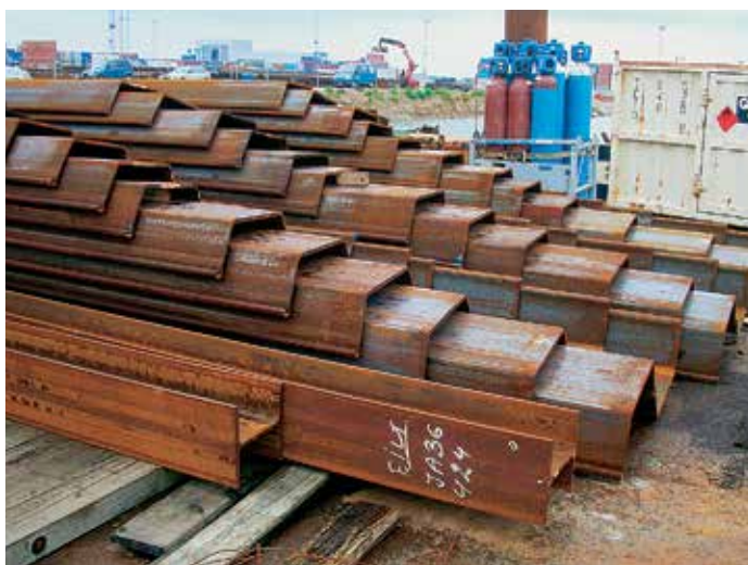
Шпунт и двутавры доставлялись до рабочей площадки баржей.
