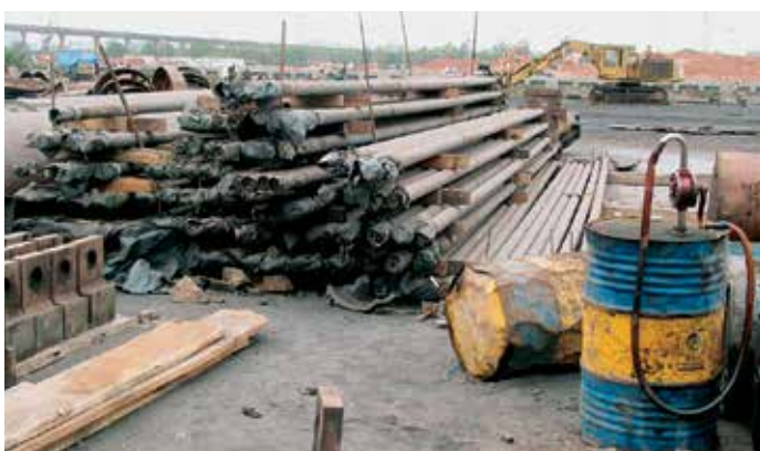
Индийское проектное бюро Howe приняло решение в пользу применения комбинированной шпунтовой системы HZ/AZ с анкерной стеной.
