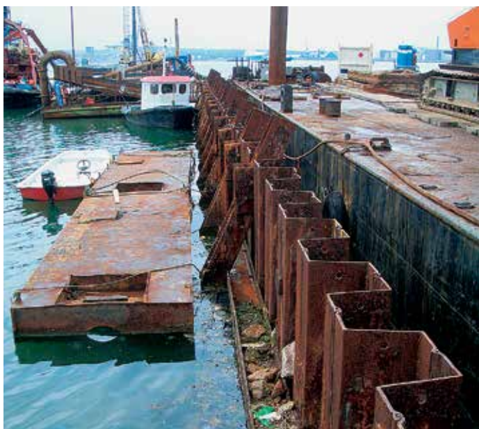
Новую причальную стенку временно подпирала наклонными сваями.
