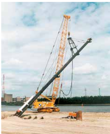
Специально изготовленные под проект анкерные сваи типа НТМ 600/136 длиной 47 м погружали с помощью гидравлического ударного молота.
