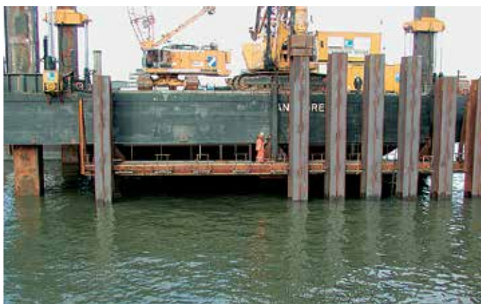
Направляющий кондуктор для сдвоенных HZ-свай.
