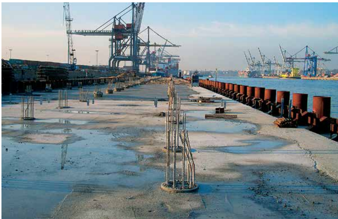
Несущие элементы конструкции причала включают шпунтовые сваи, стальные трубы, анкера, работающие.
