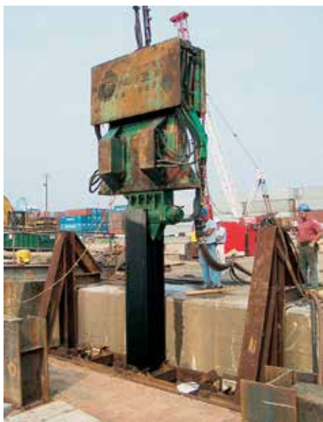
Забивка основных свай при помощи двухуровневого кондуктора.
