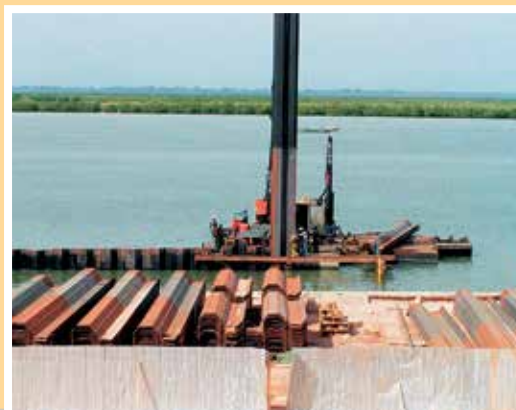
Новую причальную стенку построили из стальных шпунтовых свай типа AU 21 на расстоянии 20 м перед существующей стенкой.
