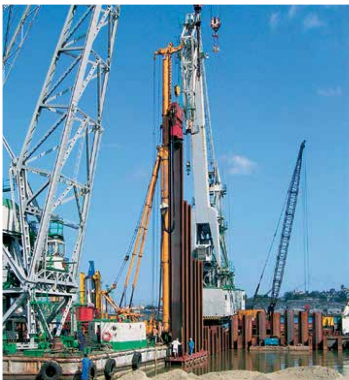
Часть свай погружали с помощью оборудования, установленного на барже, остальные – с помощью оборудования с берега.
