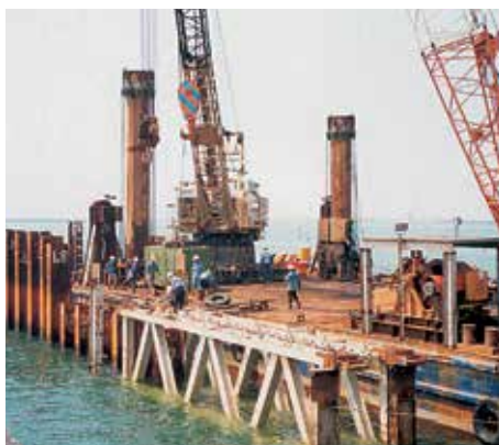
Время от времени погружение свай проводили ниже уровня воды вследствие значительных приливно-отливных колебаний.
