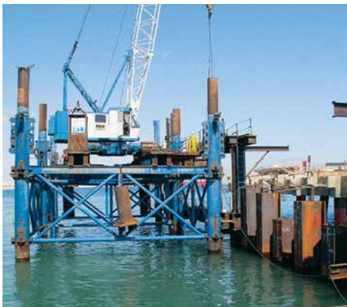
Для установки HZ/AZ-системы использовалась самоподъемная платформа и кондуктор.
