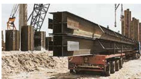
Сборные элементы шпунтовой стенки поставили на площадку точно в срок.
