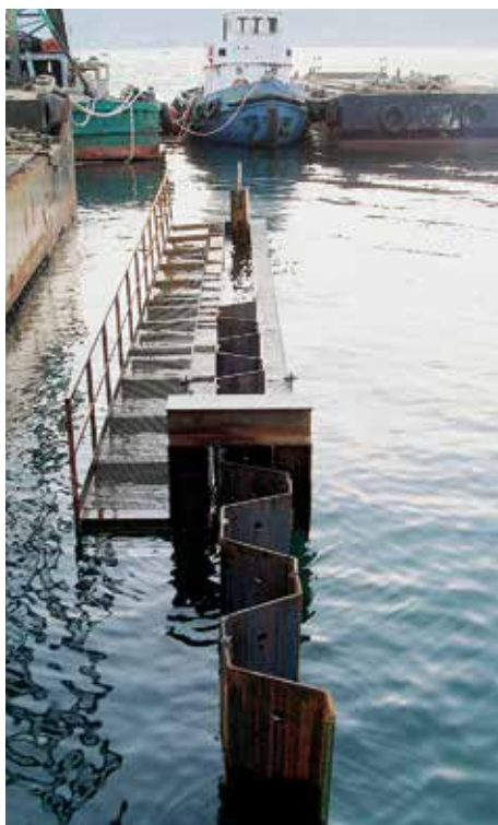
Было погружено 2600 т шпунтовых свай типа AZ 36 длиной 24 м и AZ 18 длиной 8 м.
