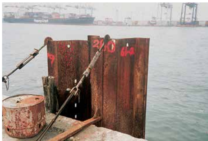
Сваи забивали вдоль стенки существующего причала.
