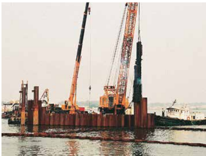
Погружение шпунтовых свай на открытой воде с помощью вибропогружателя и ударного молота, размещенных на барже.
