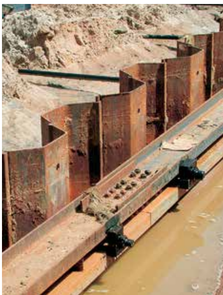
Анкерная система производства Anker Schroeder.
