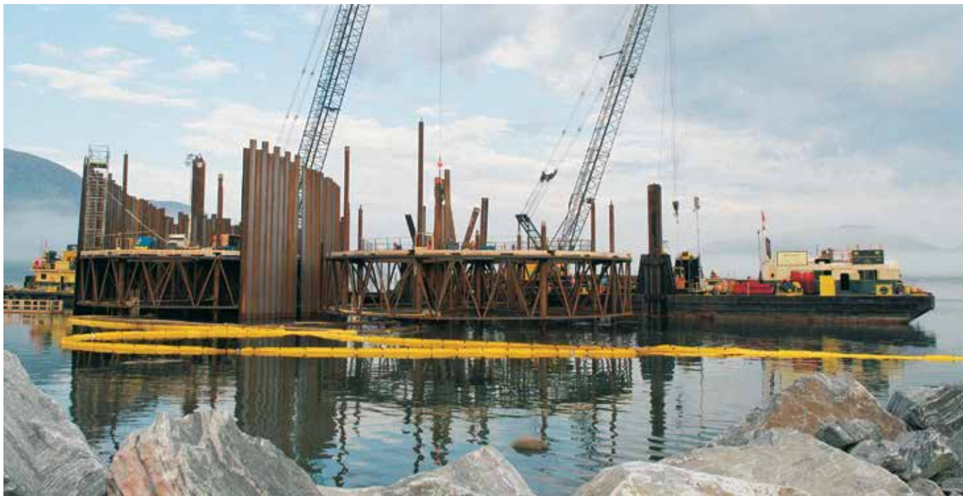
Шпунтовые сваи погружались с помощью направляющего кондуктора.
