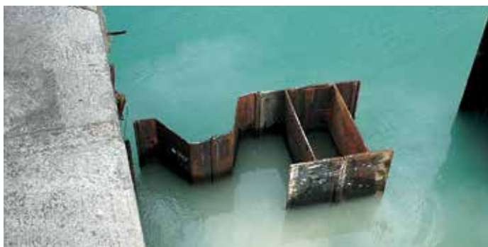
Место соединения нового и существующего причалов: к пластине, установленной на крайнем кессоне существующего причала, был приварен замковый элемент AZ-сваи для перехода на шпунтовую стенку нового причала.
