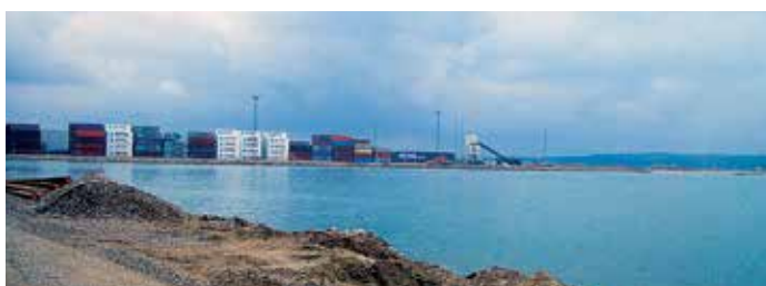
При строительстве нового крыла контейнерного терминала проводили отсыпку огромных площадей.
