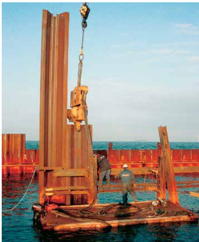
При сооружении обеих стенок коффердама задействовали несколько барж.
