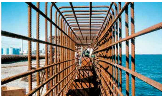
Армокаркас железобетонного оголовка.
