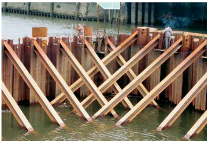
Угловые грунтовые анкера устанавливали с особой тщательностью, поскольку они пересекались на разных уровнях.
