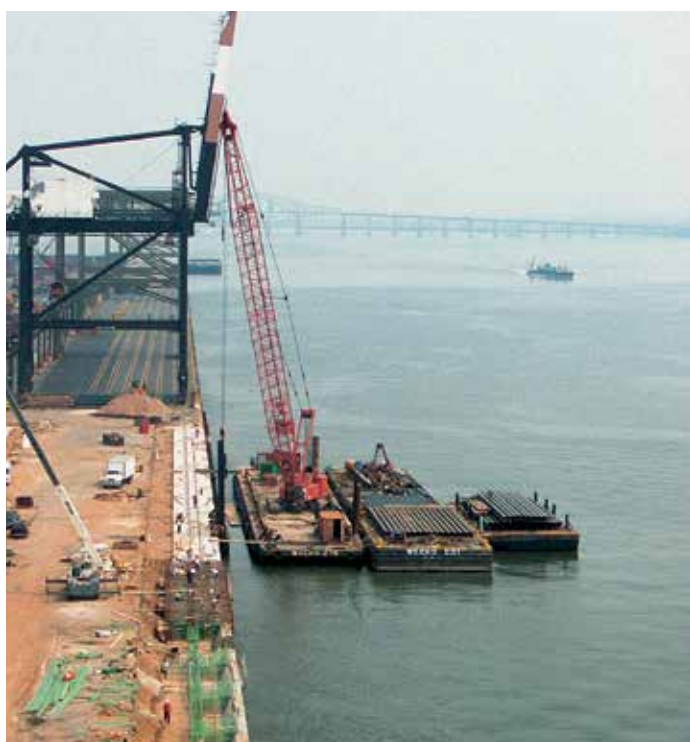
Глубина дна Морского Терминала Элизабет была увеличена с 10 м до 15,2 м.
