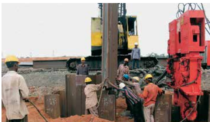
Из-за наличия скальных пород для забивки свай до проектной отметки задействовали ударный молот.
