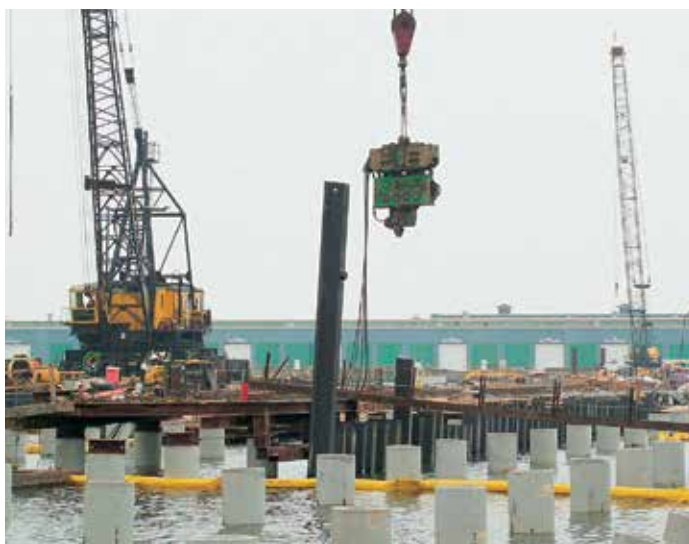
Погружение свай в гидроизоляционную стенку стока.
