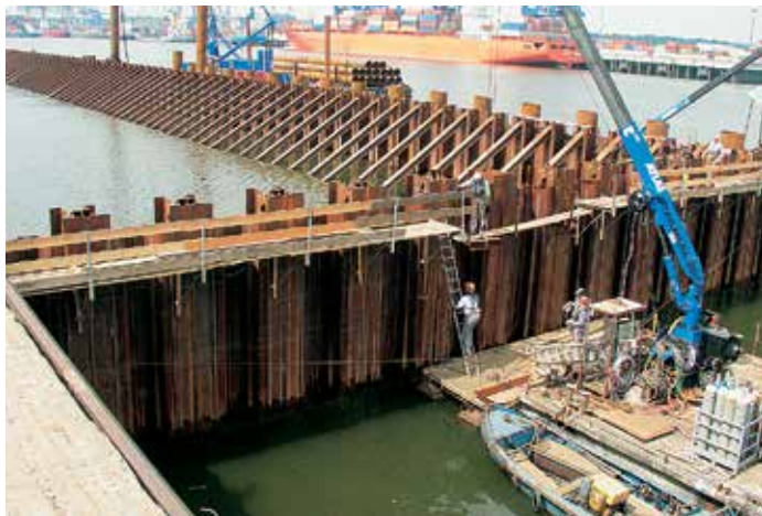
Каждая двояная HZ-свая была сопряжена со свайей HP 400 x 122, работающей на растяжение.
