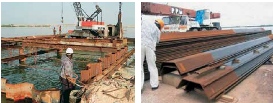
Для увеличения срока службы материалов использовали трёхслойное защитное покрытие.
