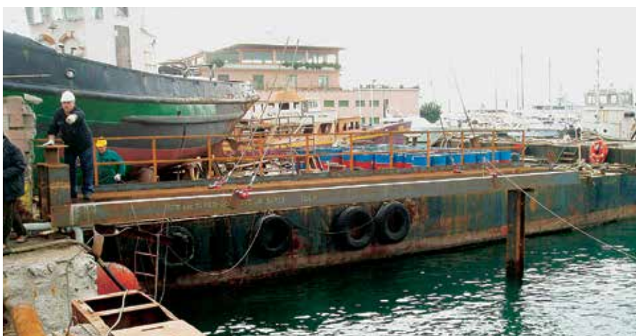
Новый пирс протяженностью 400 м будет завершен к 2006 году с использованием шпунтовых свай типа AZ 36 и AZ 18.
