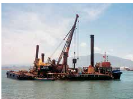
Комплект оборудования для погружения включал два крана, вибропогружатель ICE и ударный молот.
