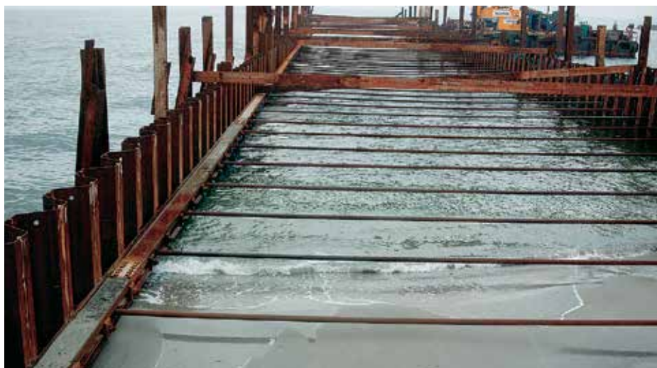
Верхний уровень стальных анкерных тяг внутри коффердама.
