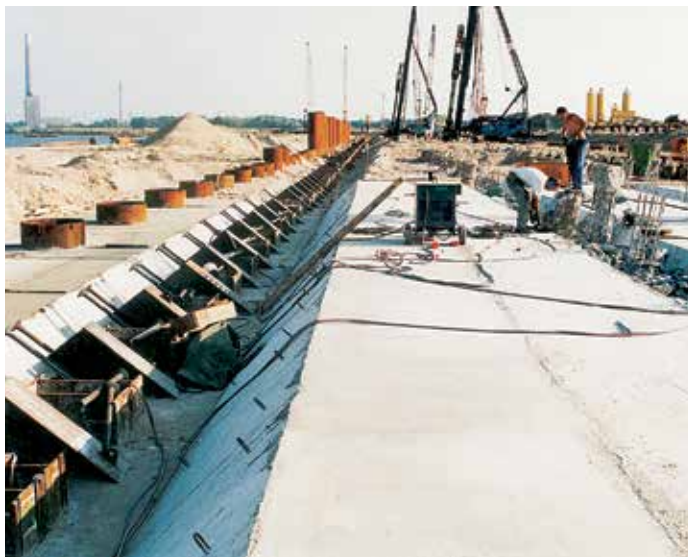
После заливки бетона разгрузочную плиту сверху засыпали 3,3-метровым слоем песка.
