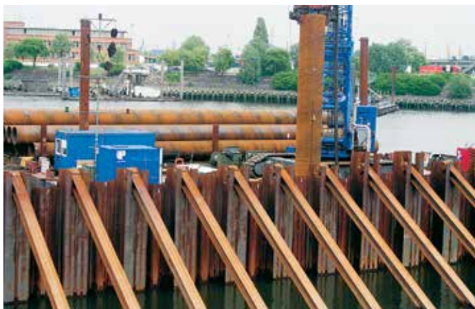
Стальные трубчатые сваи для восприятия вертикальных нагрузок и защиты от размыва грунта у причальной стенке.
