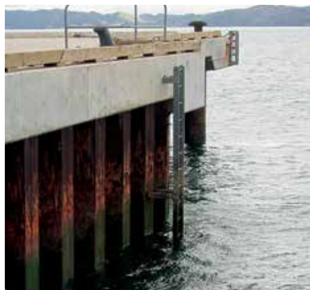
Причал длиной 390 м с обоих торцов завершают открытки.
