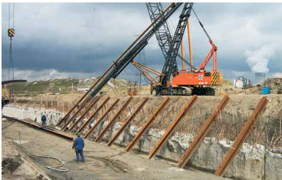
Стальные сваи MV воспринимают растягивающие усилия входных стенок.
