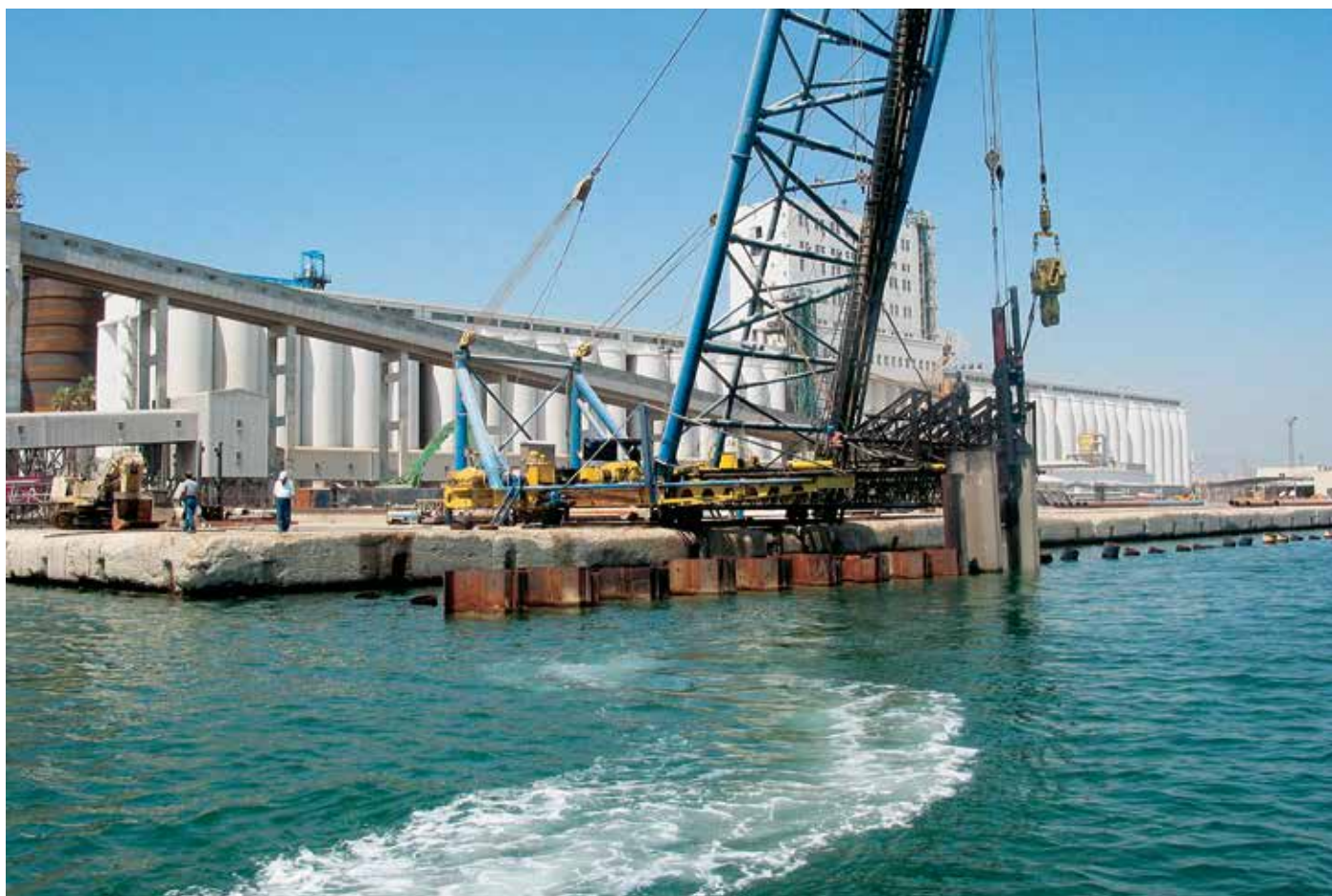
Существующее бетонное строение модернизировали с помощью зубчатой стенки из шпунтовых свай.
