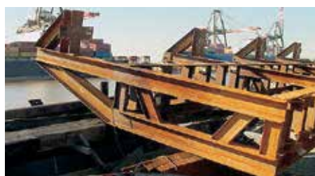
Панели из неопрена, установленные на кондукторе, обеспечивали защиту покрытия сваи при их погружении.
